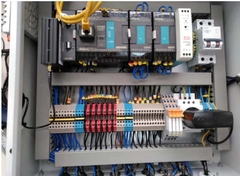
Armario secundario: conexión de sensores.
