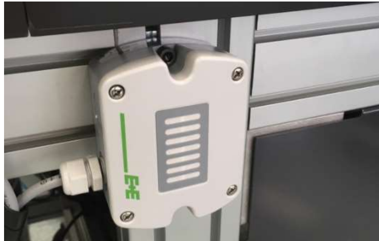
Sensor de CO2 instalado en la línea para medición de condiciones ambientales
