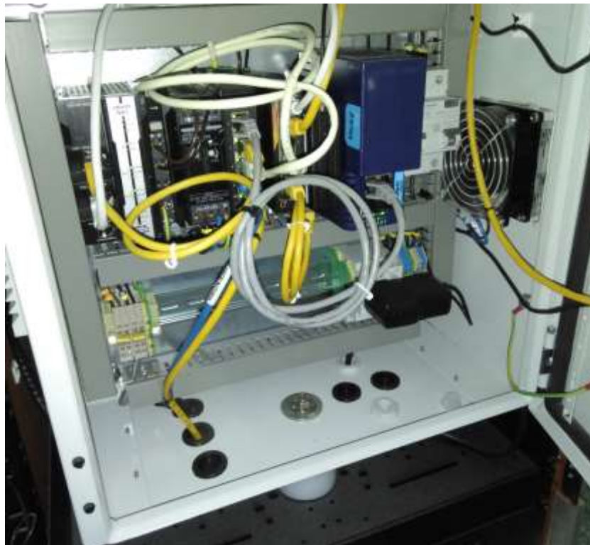
Armario principal: Controlador principal con driver OPC-UA y Base de datos
