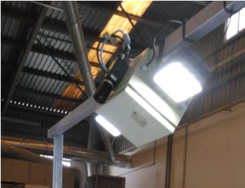
Sistema de visión artificial y su sistema de iluminación, montados en una empresa
